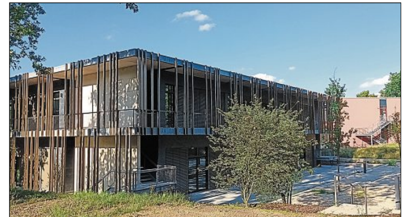
Die AOK Bayern hat rund 35 Millionen Euro in den Neubau investiert.
