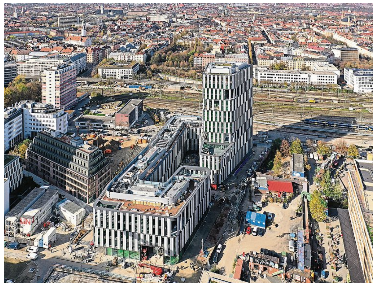
Kurz vor der Fertigstellung des neuen Wahrzeichens des Werksviertels.
