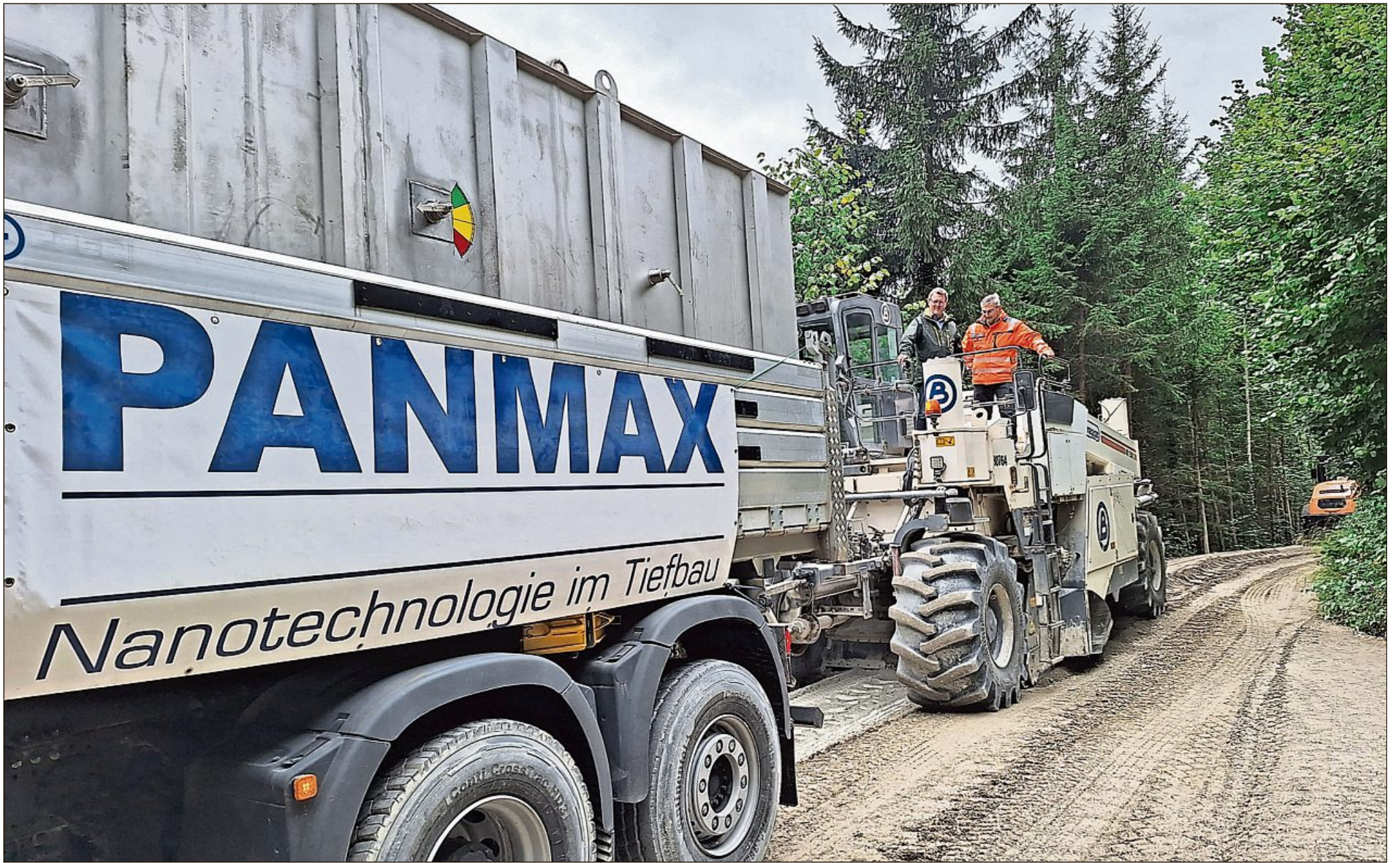
Das Panmax-Team führt mit viel Erfahrung und Können den Straßenbau der Zukunft aus.
