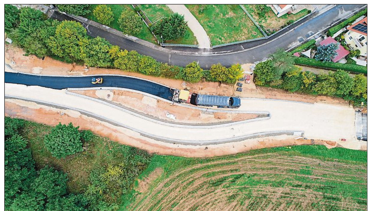
Die Fahrbahnverschnenkung im Bau.
