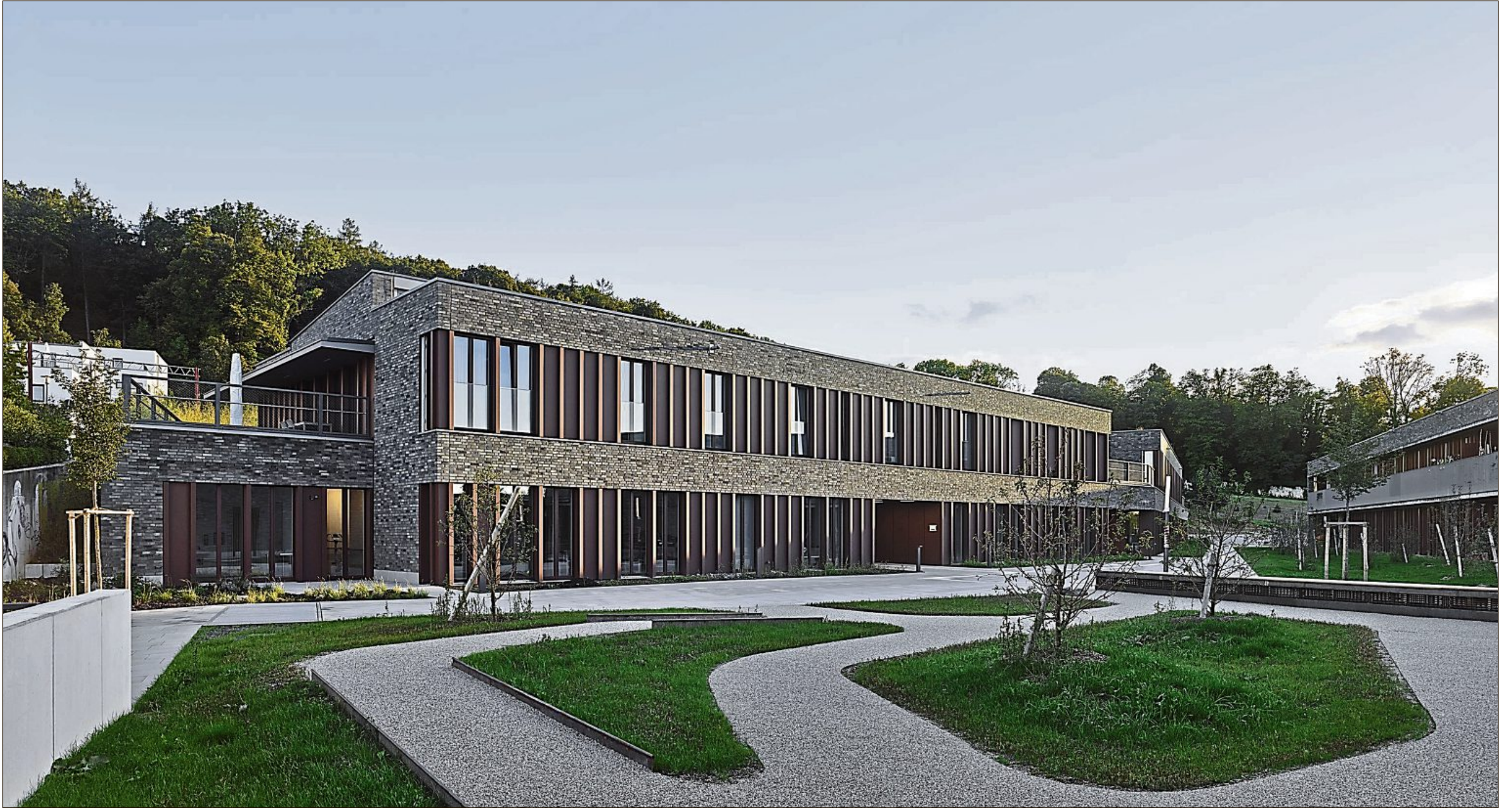
Der Erweiterungsbau der Blindeninstitutsstiftung Regensburg verfügt unter anderem über 24 Wohnungen.
