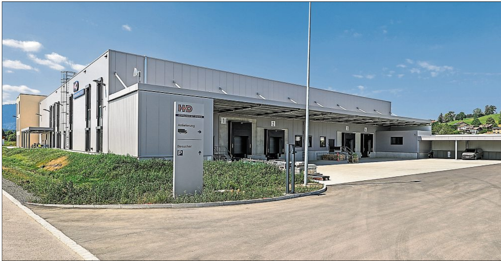
Die neue Montage- und Lagerhalle.
