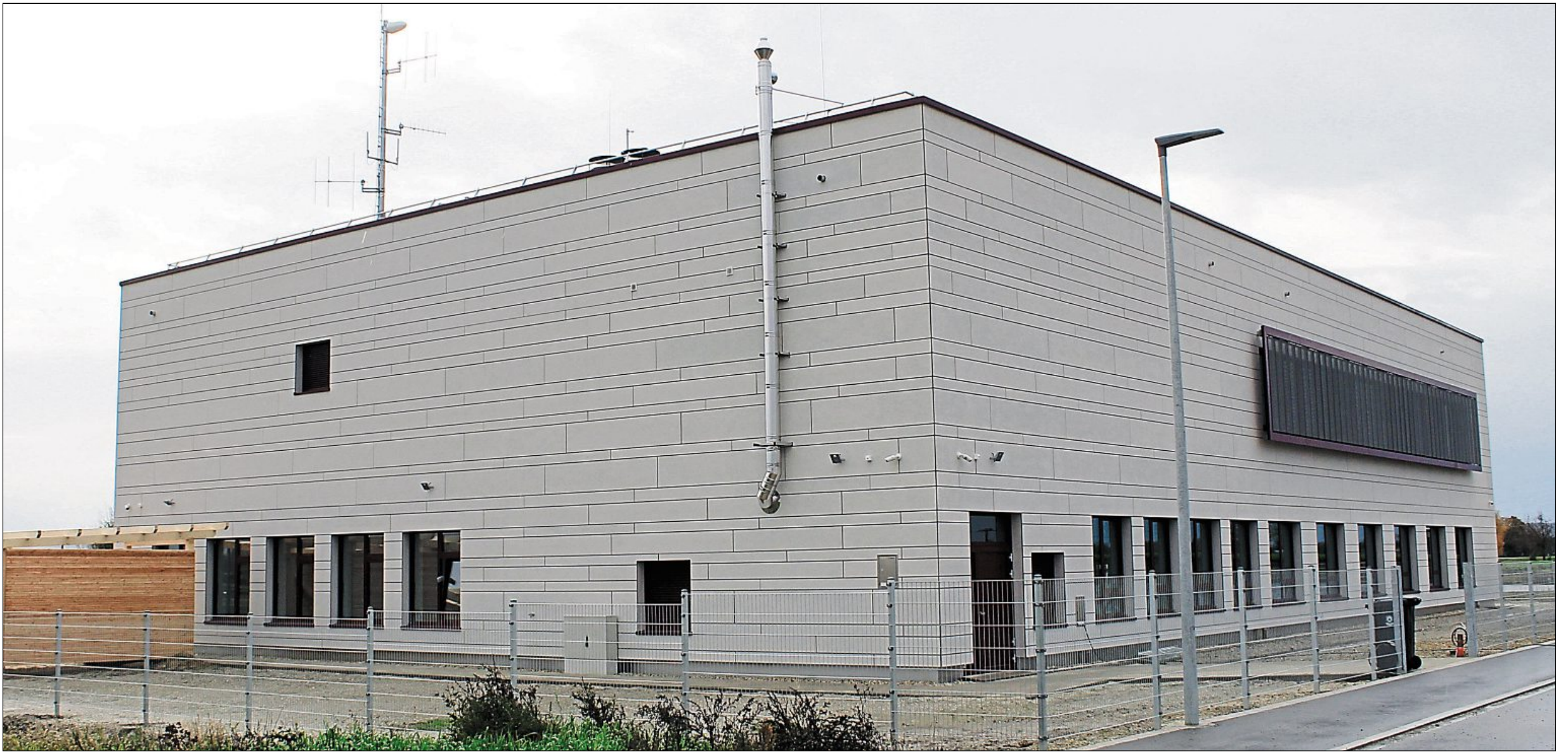
Knapp zwei Jahre nach Baubeginn ist die Integrierte Leitstelle in Essenbach in Betrieb gegangen.
