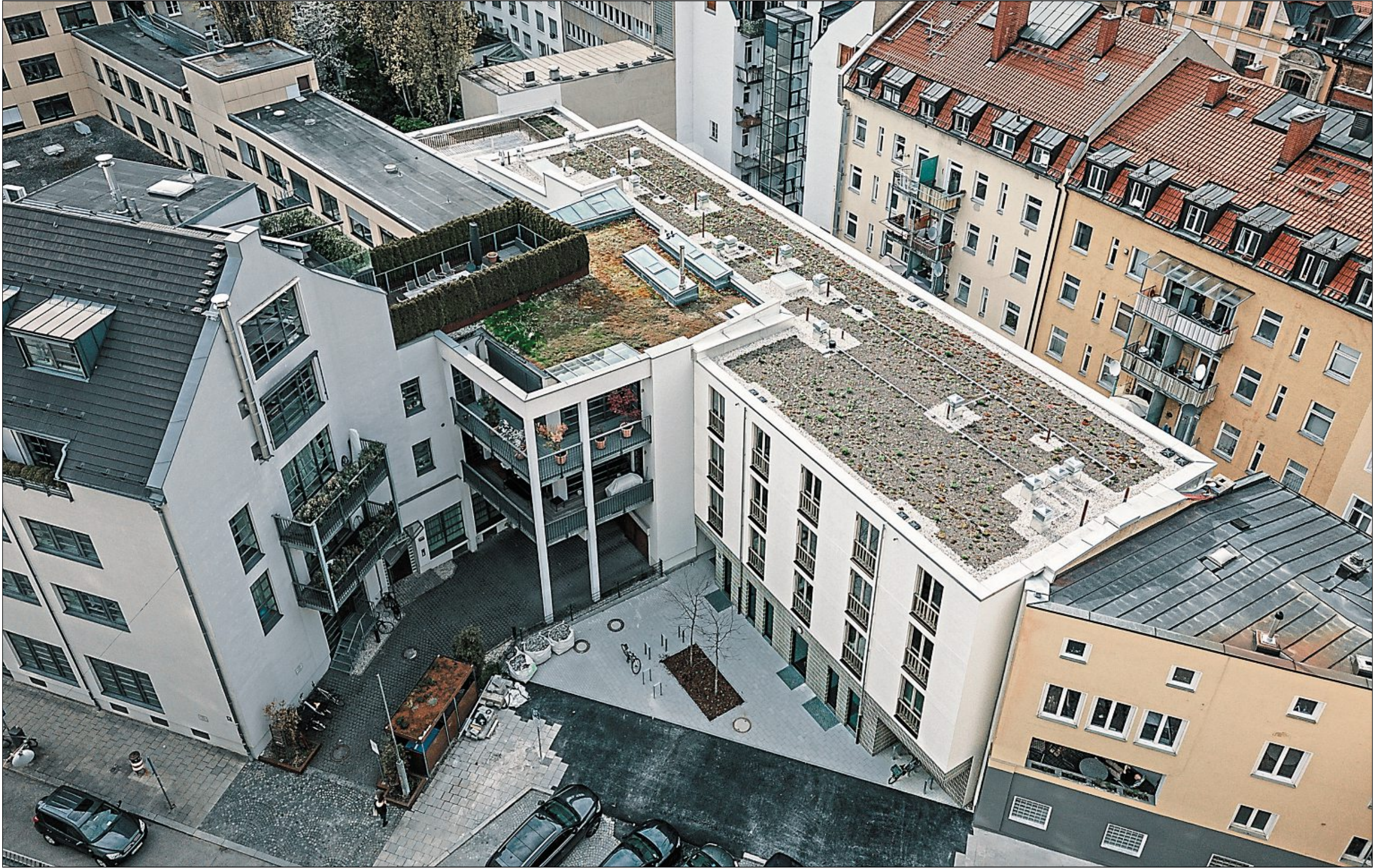
Beste Lage, komplizierte Baustelle: Das Drohnenfoto zeigt, auf welchem beengtem Raum das neue Gebäude entstanden ist.
