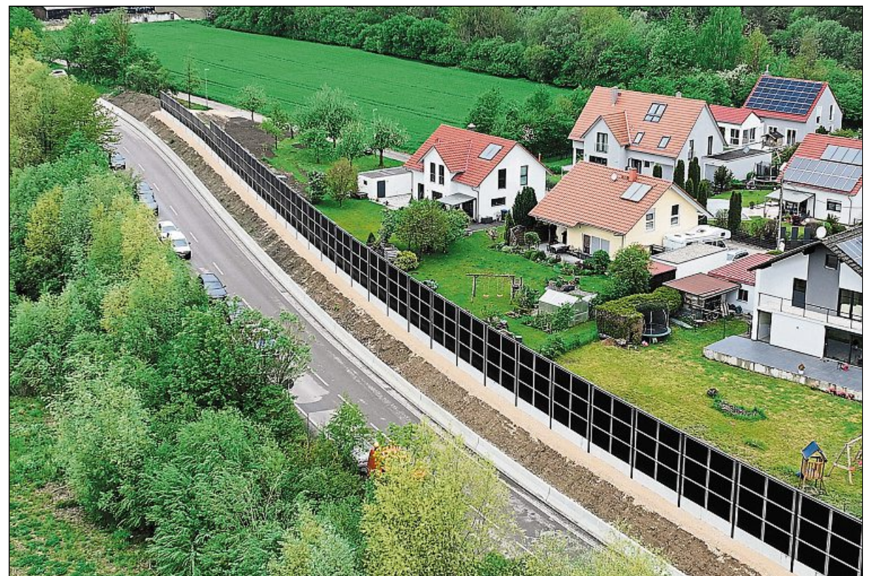
Die neue Lärmschutzwand mit der integrierten Photovoltaikanlage.
