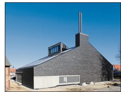
Die Energiezentrale auf dem Lagarde-Campus in Bamberg. FOTO: MARKUS REINFELS
