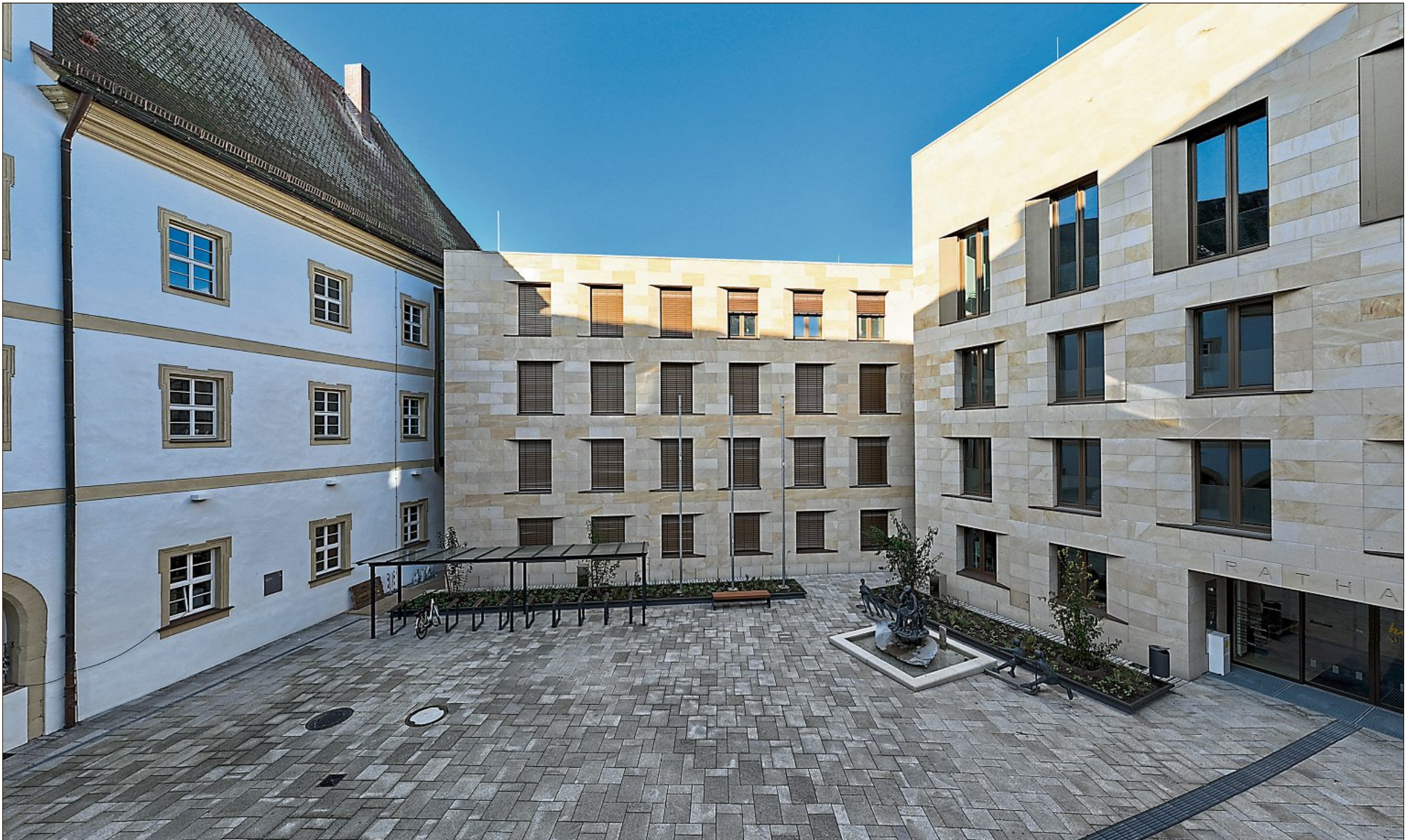
Die Fugen zwischen Schloss und Neubau schaffen Eigenständigkeit.
