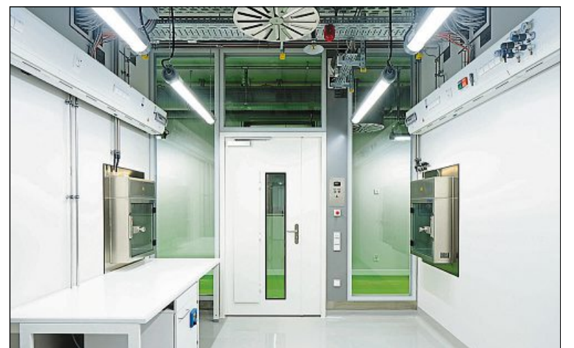
S3-Labor im ersten Untergeschoss.
