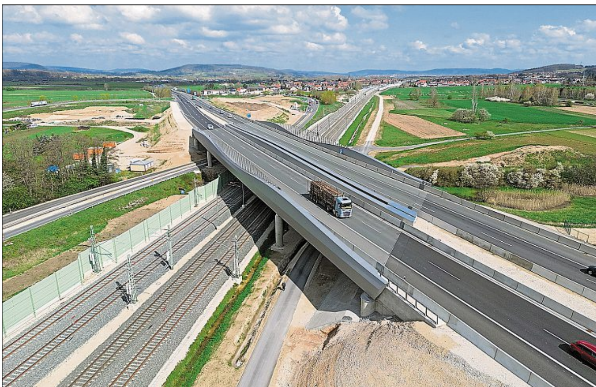
Die offizielle Verkehrsfreigabe der Gesamtmaßnahme erfolgte im Oktober 2022.
