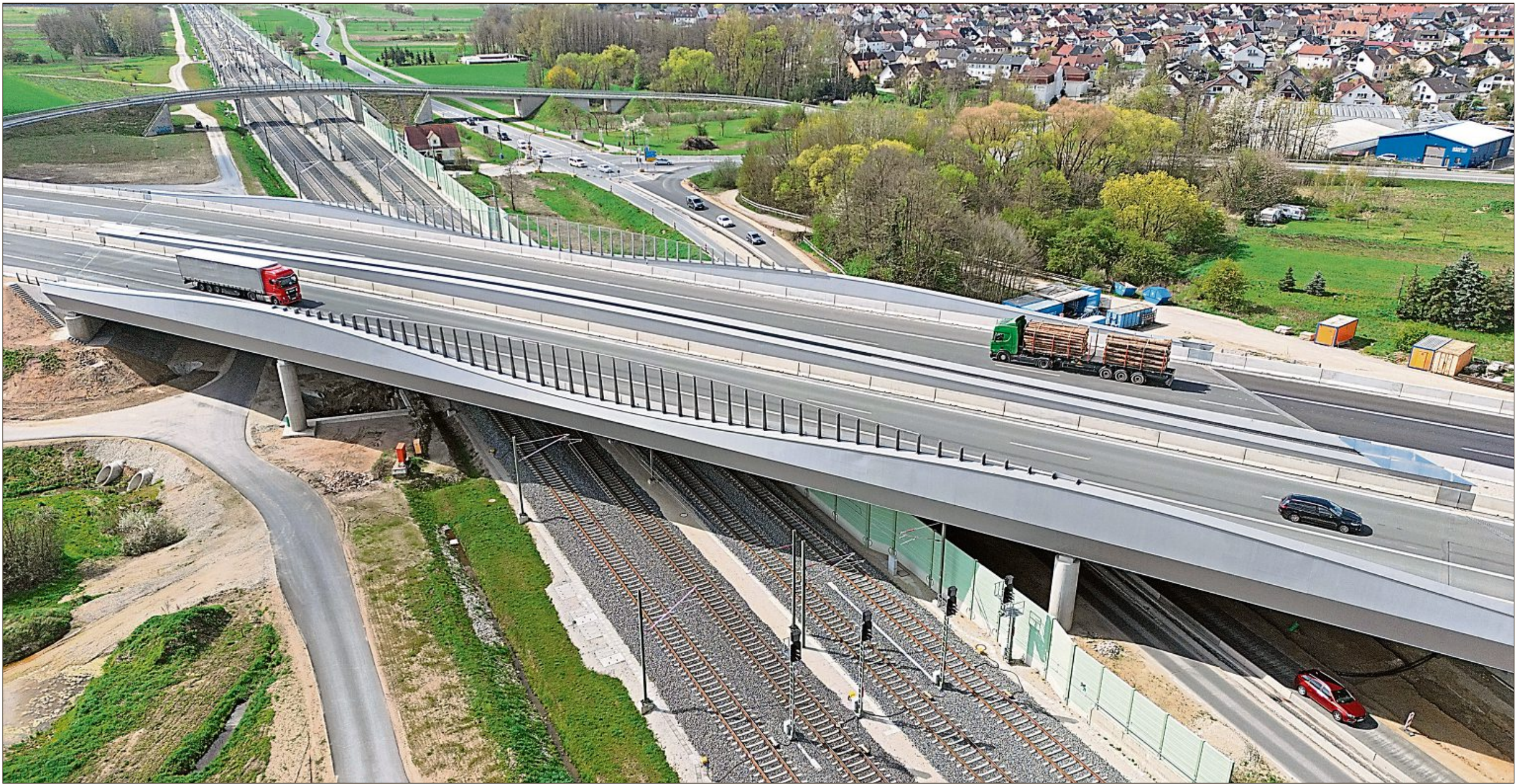
Die neue Autobahnbrücke über die viergleisige Bahnstrecke Nürnberg – Ebersfeld.
