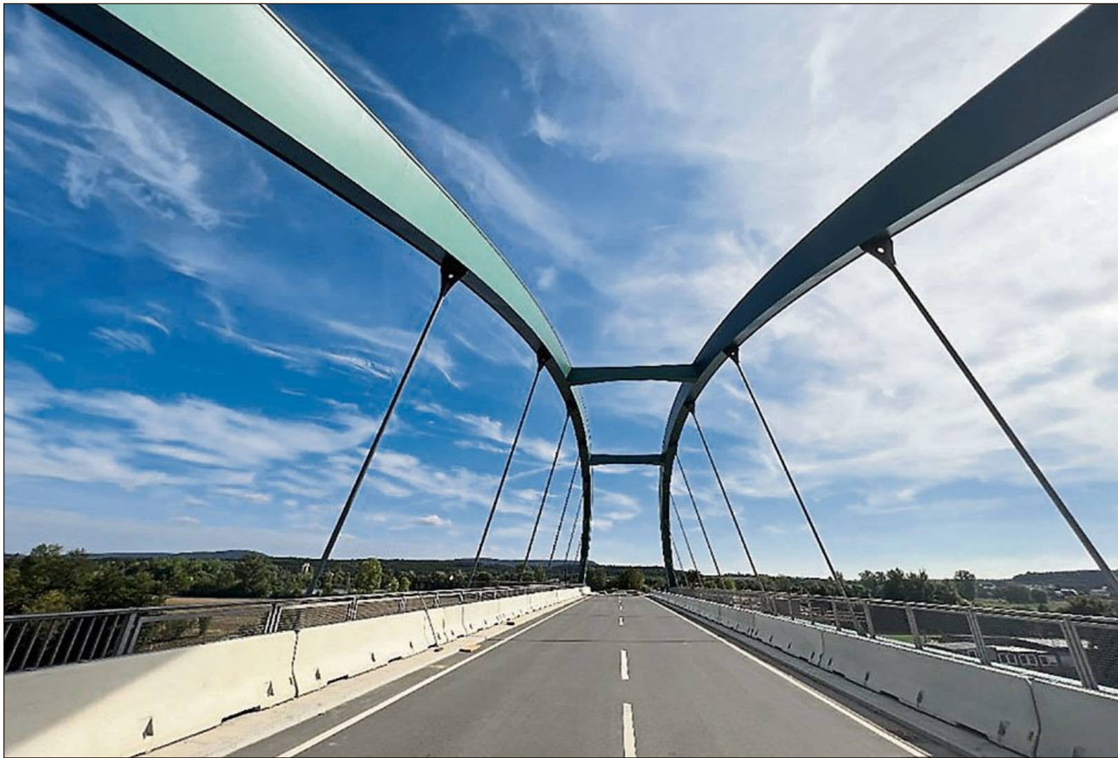
Die Stabbogenkonstruktion unmittelbar vor der Verkehrs freigabe.
