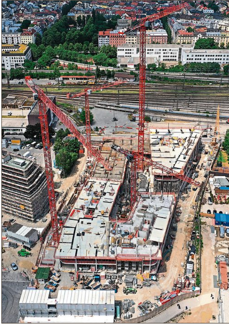
Das Optineo während der Bauphase.
