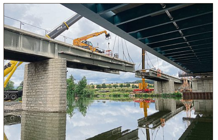
Eingeschwommener Stabbogen in Seitenlage – Blick in die Schalung. Abbruch des Mittelteils des Bestandsbauwerks.
